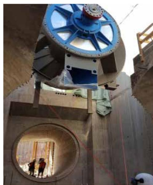
Die neue Rohrturbine beim Einbau 2018
